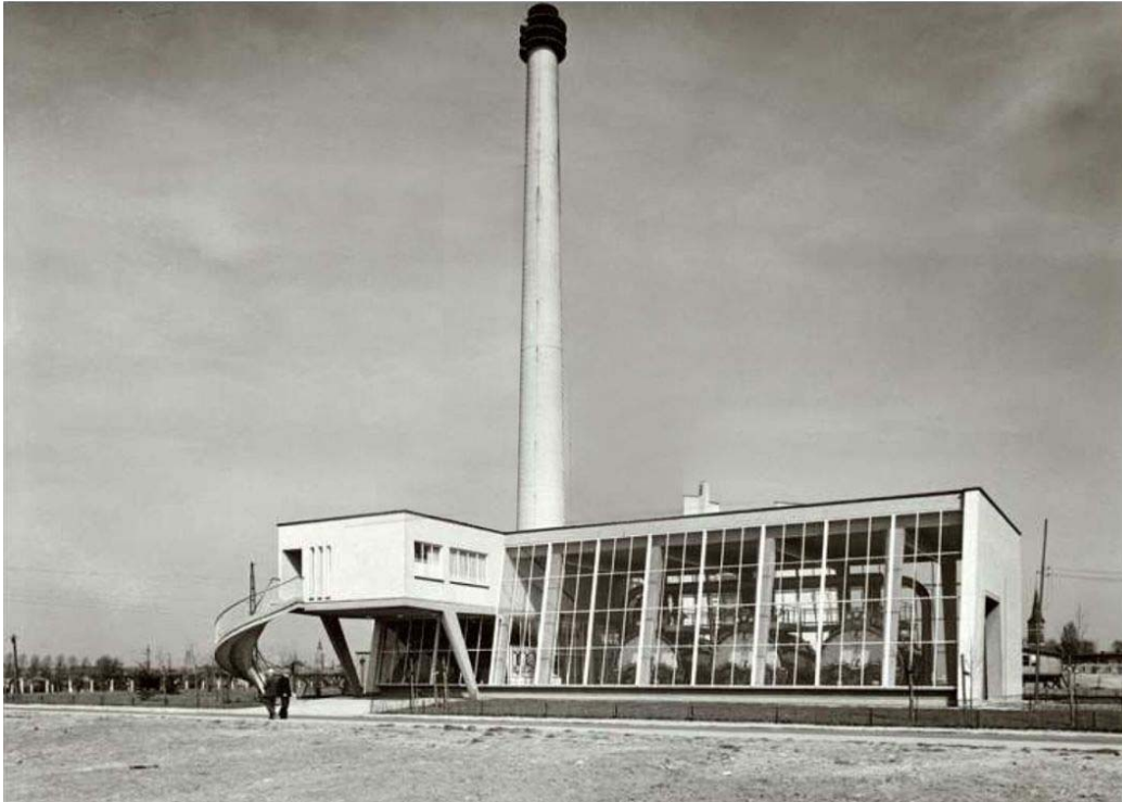
Stookplaats voor gemeenschappelijke verwarming van de “Potenblokken”, een sociale woonwijk op het Kiel, arch. Renaat Braem, 1951-1958
